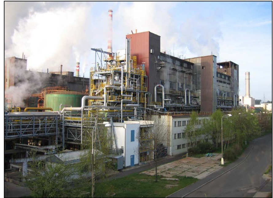
Vřesová IGCC Plant, Czech Republic
